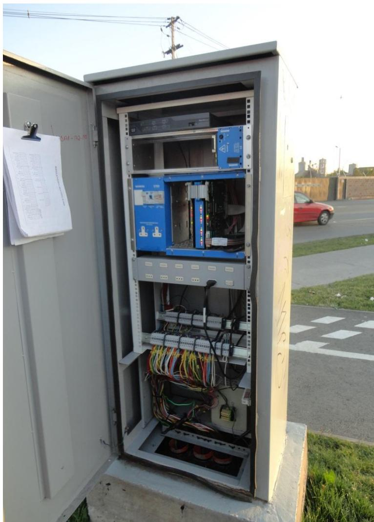
A Foto 5 apresenta um controlador ST900 utilizando OTU UTMC. Observe que não foi utilizada nenhuma placa de I/O.
