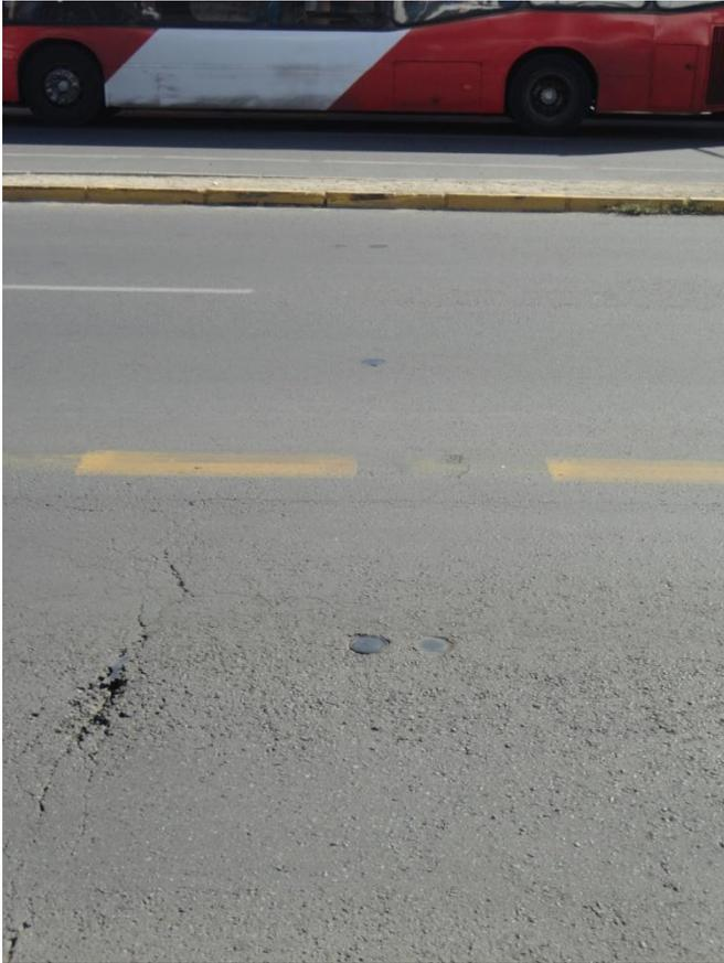
Foto 8 – Seção de detecção de sensores de campo magnético Sensys
