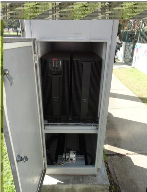
A Foto 2 mostra o gabinete do nobreak aberto. O equipamento da esquerda é o nobreak e o da direita é o conjunto de baterias. Potência do nobreak: 500watts; Autonomia: 3 horas
